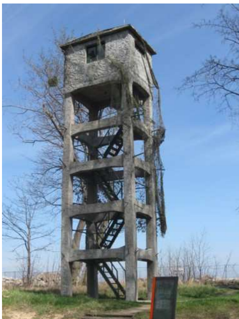
2. Wieża Zapasowego Punktu Kierowania Ogniem - konstrukcja wzniesiona po II wojnie światowej
