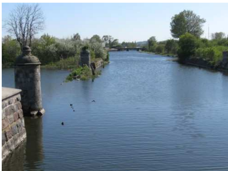
24. Śluza Kamienna - arcydzieło XVII-wiecznej myśli technicznej
