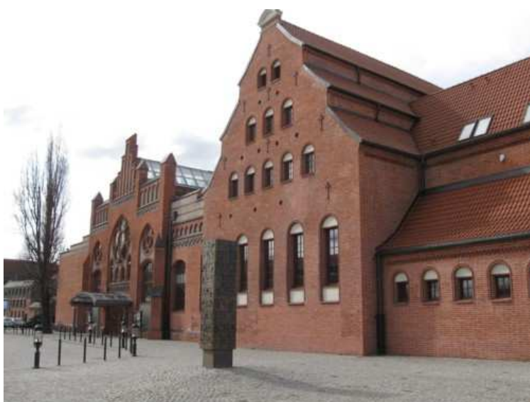
11. Filharmonia działa w obiekcie dawnej elektrociepłowni
